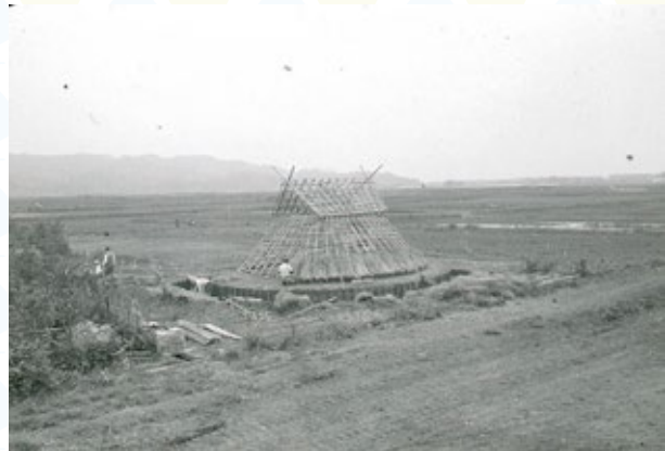
旧復元住居の建築風景
